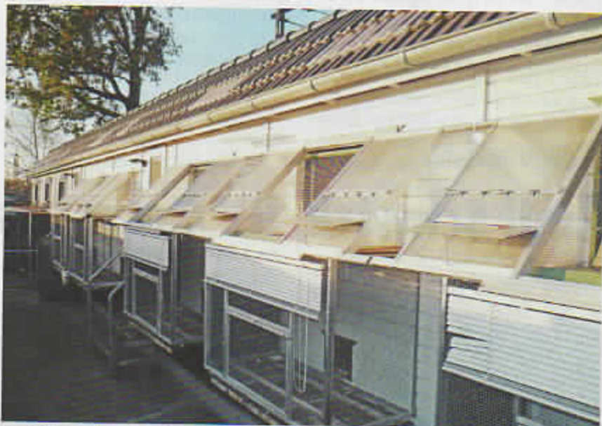
Die Schlaganlage wurde von Ulrich Köster im Herbst 2007 erstellt. Für die totale Witterschaft stehen 3 Abteile zur Verfügung, die etwa 70-80 Jungtauben finden in zwei Schlägen Platz. Dem Schlag gegenüber steht ein Gesellschaftsgebäude, an das noch ein kleiner Zuchtschlag angebaut wurde.
